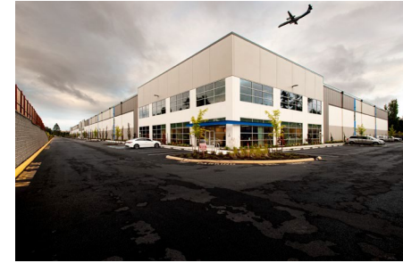
NERA 3 completed 2019 (Burien, WA)
