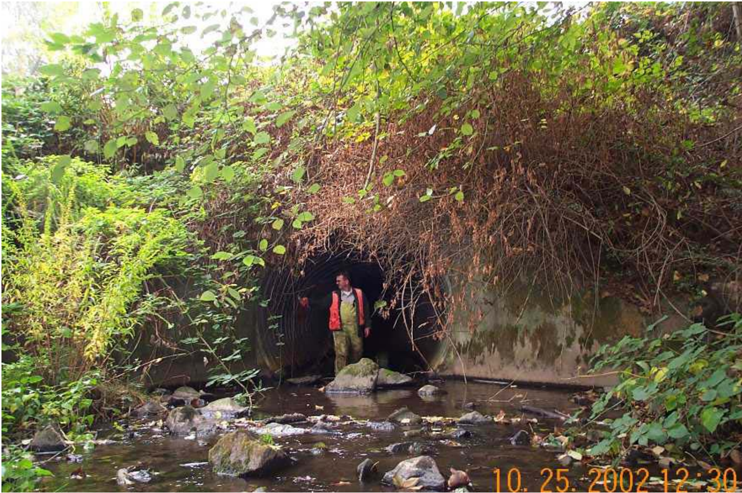
Miller Creek culvert at 1 st Av S
